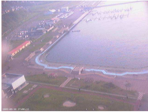
図3: 飛行ロボットを用いて上空から撮影された画像データの一例
